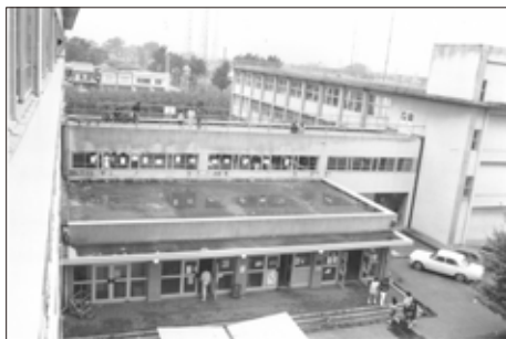
管理棟との連絡通路と昇降口
